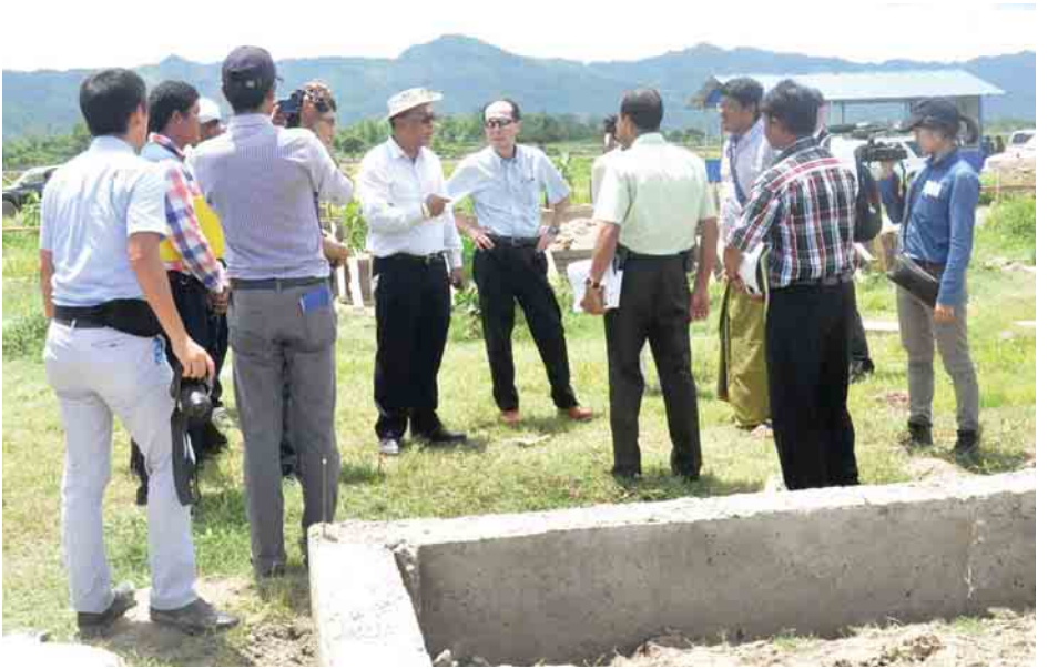
ဒုတိယဝန်ကြီးများနှင့် ဂျပန်သံအမတ်ကြီး ဦးဆောင်သောအဖွဲ့၊ ကြိမ်ချောင်း(တောင်)ရွာ၌ နေအိမ်များတည်ဆောက် နေမှုကို ကြည့်ရှုလေ့လာစဉ်။
