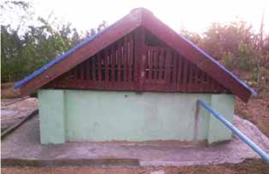
ဂွမြို့နယ် ကွင်းကြီးတောင်နားကျေးရွာ အလကကျောင်းတွင် ရေစုကန်တည်ဆောက်ခြင်းနှင့် ရေပိုက်လိုင်း သွယ်တန်းခြင်းလုပ်ငန်းများ ဆောင်ရွက်ပြီးစီးမှုကို တွေ့ရစဉ်။
