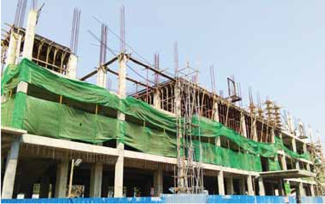
ကျန်းမာရေးနှင့် ကုသရေးအတွက် စစ်တွေပြည်သူ့ဆေးရုံကြီးတွင် လေးထပ်ဆောင် ထပ်မံတိုးချဲ့တည်ဆောက်နေစဉ်။
