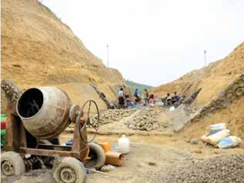
စိုက်ပျိုးရေးနှင့် သောက်သုံးရေရရှိရေးအတွက် မောင်တောမြို့နယ် ကိုင်းကြီးကျေးရွာအနီး တစ်ဖက်ပိတ်ဆည် တည်ဆောက်စဉ်။
