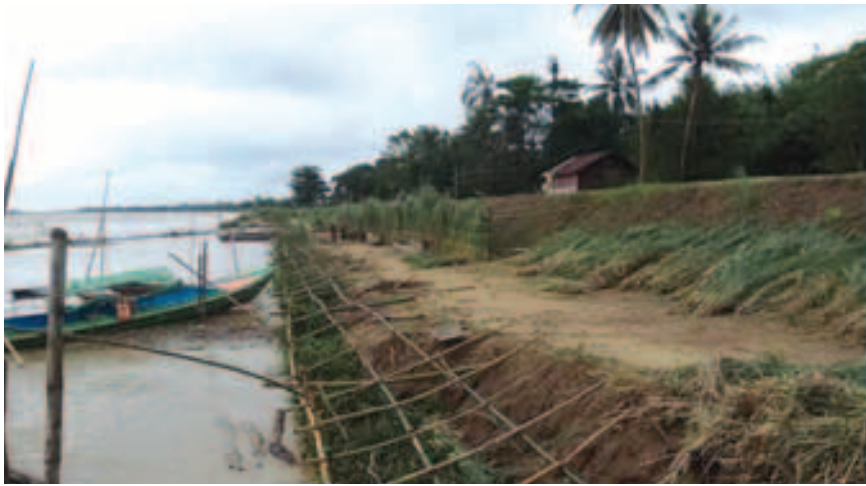
ခန့်ဖြူမြို့နယ် အရှေ့ဘက်ကမ်း (စံကင်း) ဖြတ်တာသစ် လှိုင်းပုတ်ဒဏ်ခံနိုင်စေရန် ရေကာတာ အပေါ်ပေ ၄၃၀ နှင့် အောက်ခြေ ပေ ၄၃၀ အရှည် လှိုင်းကာတန်းရိုက်၍ ဆည်မြောင်းနှင့် ရေအသုံးချမှုစီမံခန့်ခွဲရေးဦးစီးဌာနမှ ဦးစီးအရာရှိ ဦးမြင့်ဦးနှင့်ဝန်ထမ်းများကကြိုတင်ကာကွယ်ရေးဆောင်ရွက်လျက်ရှိကြောင်းသိရသည်။ အောင်သူဟိန်း(ပြန်/ဆက်)
