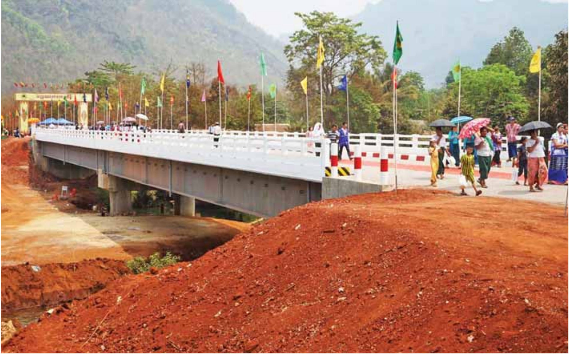
ကြာအင်းဆိပ်ကြီး-ချောင်းဆုံ (ဘုရားသုံးဆူ)လမ်းပေါ်ရှိ မက္ကသာတံတားကို တွေ့ရစဉ်။
