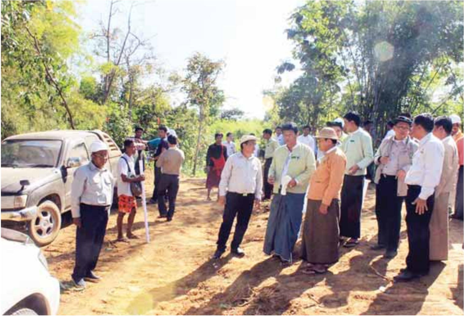
ဖားရွှေကျော် (နိုးမပြတ်ကျော်လမ်းသစ်) ဖောက်လုပ်နေမှုအခြေအနေကို တိုင်းဒေသကြီးဝန်ကြီးချုပ် ကြည့်ရှုစစ်ဆေးစဉ်။
