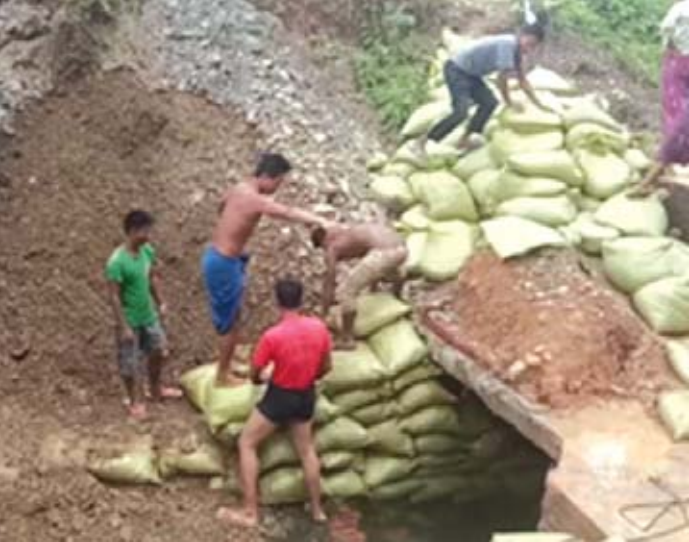
လုပ်သား ၄၀ က မြေကော်စက် ယန္တရား ယာဉ်တစ်စီး၊ မော်တော်ယာဉ်ကြီး ခြောက်စီးတို့ဖြင့် နေ့ ည အဆိုင်းများခွဲကာ ပြင်ဆင်ဆောင်ရွက်လျက်ရှိပြီး အဆိုပါနေရာတွင် မကြာမီကာလအတွင်း အရှည် ၁၀ ပေ၊ အကျယ်ပေ ၆၀ ရှိ အဆင့်မြင့် အာရုံစိုက်ကရစ်တံတား တည်ဆောက်ပေးသွားမည်ဖြစ်ကြောင်း သိရသည်။ ဦးလေးကြီး
