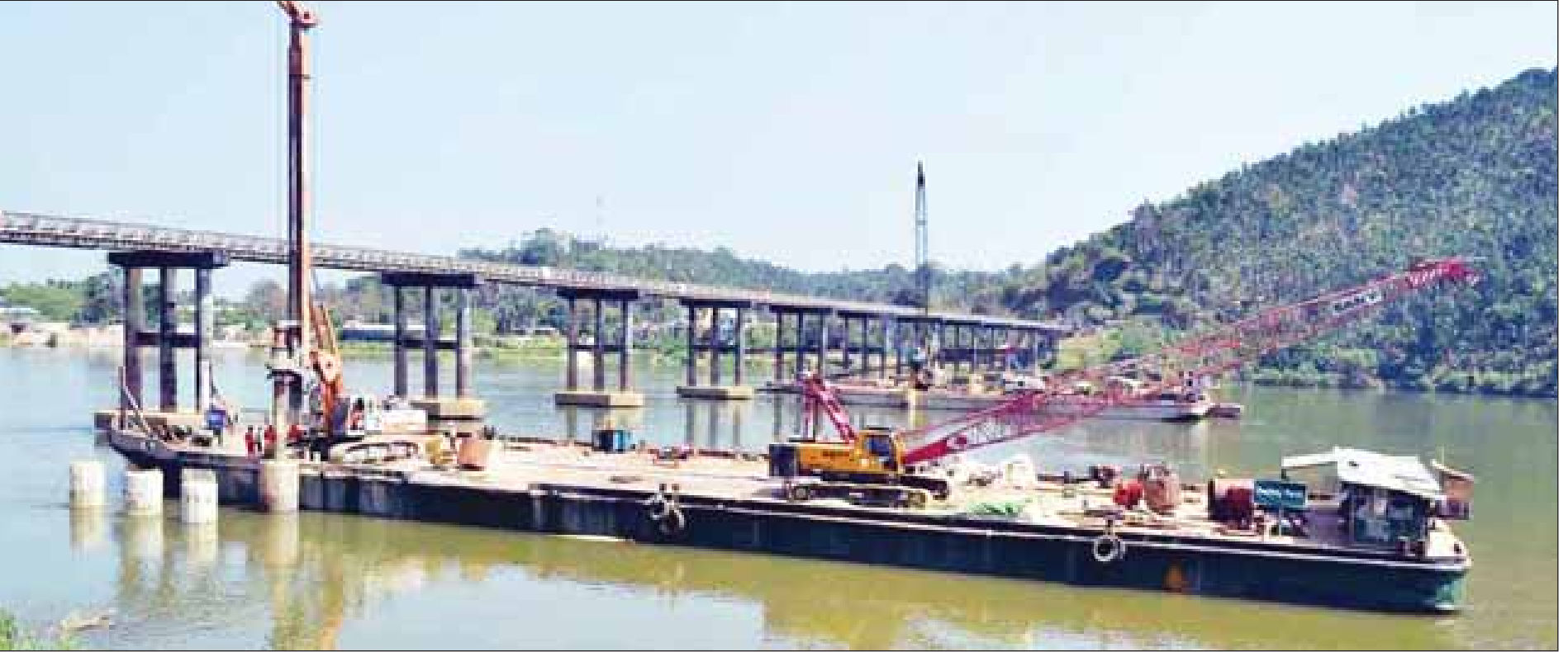
ရန်ကုန်-မြိတ်-ကော့သောင်း ပြည်ထောင်စုလမ်းမကြီးပေါ်တွင် တည်ဆောက်လျက်ရှိသော တနင်္သာရီတံတား စီမံကိန်းလုပ်ငန်းခွင်ကို တွေ့ရစဉ်။
