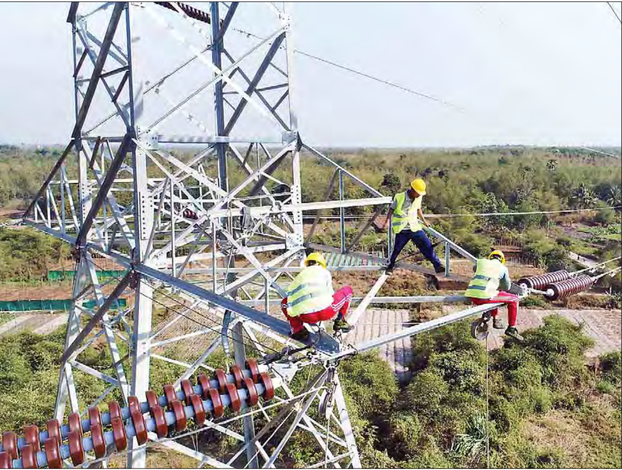
တွံတေးမြို့နယ်၌ တာဝါတိုင်အမှတ်(၇၂) ကြိုးဆွဲခြင်းလုပ်ငန်း ဆောင်ရွက်နေစဉ်။
