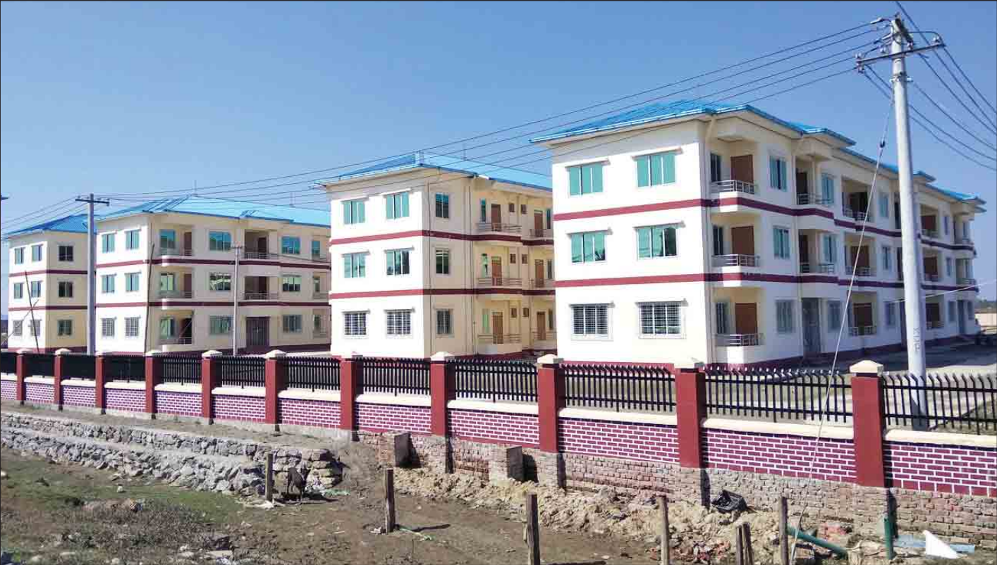
စစ်တွေမြို့ ရွှေပြည်သာရပ်ကွက်၌တည်ဆောက်ထားသည့် တန်ဖိုးနည်းအိမ်ရာများကို တွေ့ရစဉ်။
