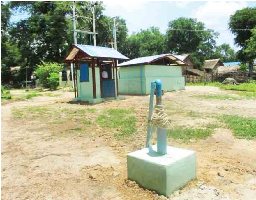
ဥက္ကရာဇ်ရှိ ပုဗ္ဗသီရိမြို့နယ်အတွင်း ရက် ၁၀၀ စီမံချက်ဖြင့် ဆောင်ရွက်သည့် ဝဲကြီးကျေးရွာအုပ်စု ကျောင်းကုန်းကျေးရွာ စက်ရေတွင်း (တွင်းနက်) တူးဖော်ဆောင်ရွက်ထားစဉ်။
