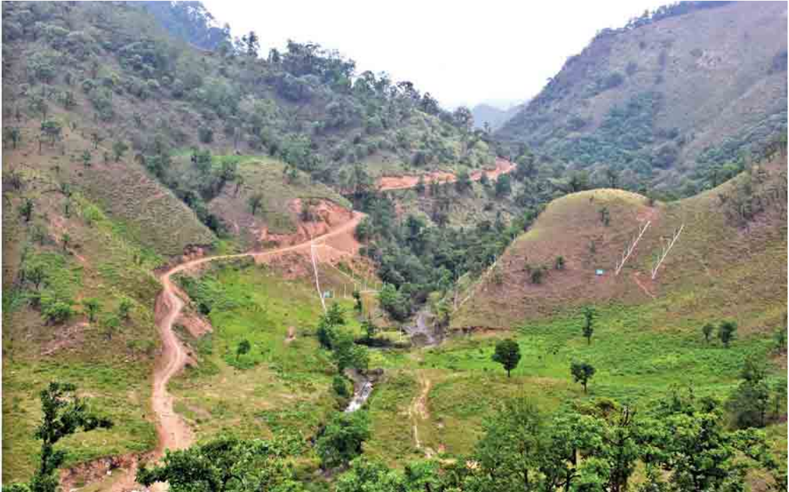
ဒုတိယသမ္မတ ဦးဟင်နရီပန်ထီးယူ ဖလမ်းမြို့နယ် တလန်းဇာရ်ကျေးရွာအနီးရှိ လိုင်ဗားတမံ (အောက်တမံ) တည်ဆောက်မည့်နေရာကို ကြည့်ရှုစစ်ဆေးစဉ်။
