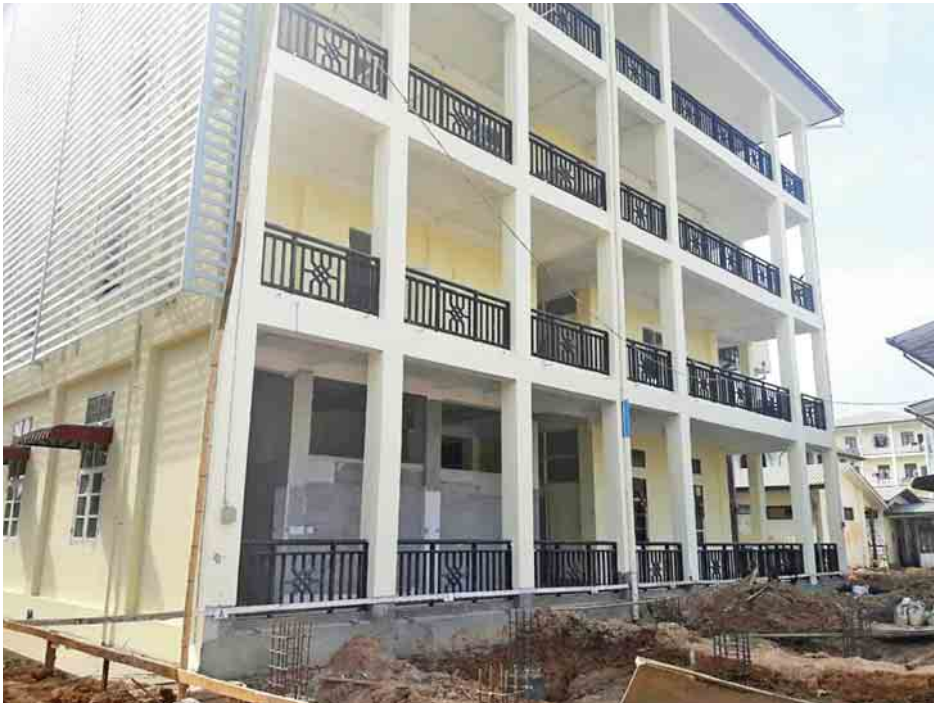
မြောင်းမြပြည်သူ့ဆေးရုံ ခုတင် (၂၀၀) ဆံ့ တိုးချဲ့လူနာဆောင်သစ် ဆောက်လုပ်နေမှုကို တွေ့ရစဉ်။
