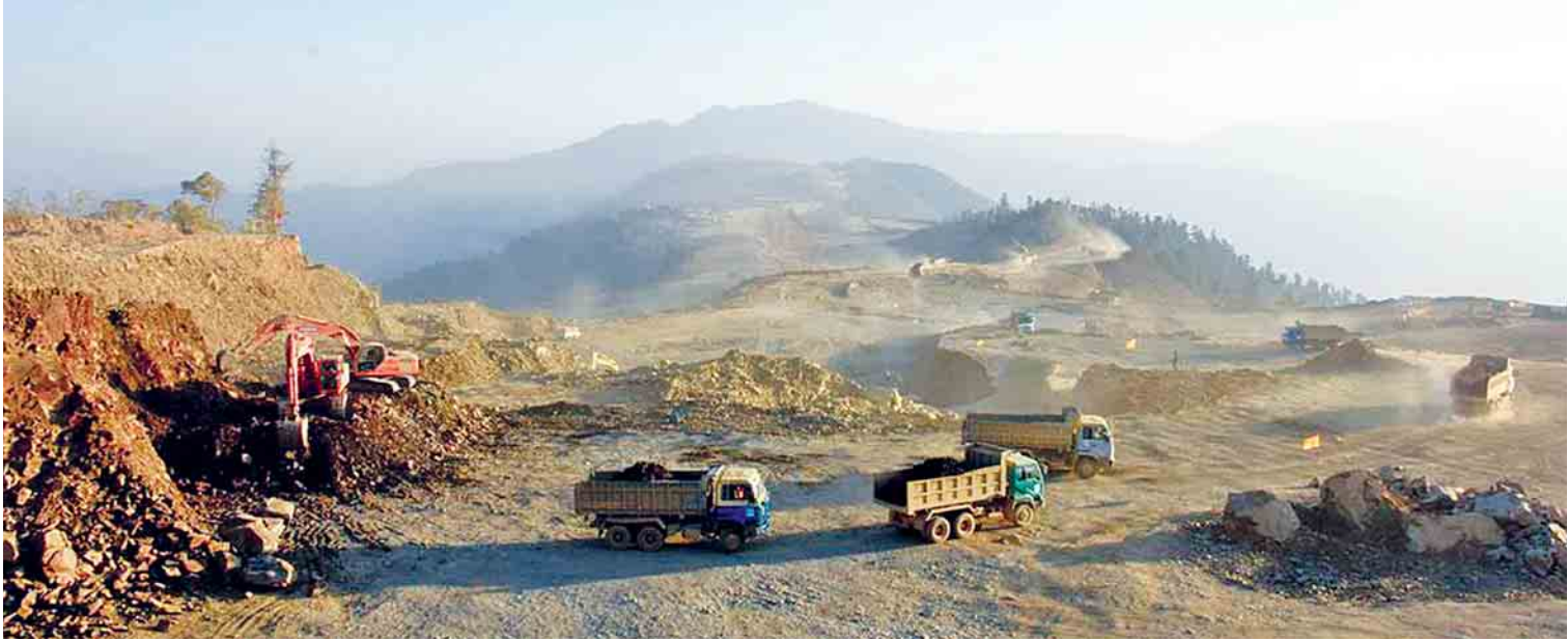
ချင်းပြည်နယ် ဖလမ်းမြို့နယ်ရှိ ဆူရ်ဘုံလေဆိပ် တည်ဆောက်ရေးလုပ်ငန်းခွင်ကို တွေ့ရစဉ်။
