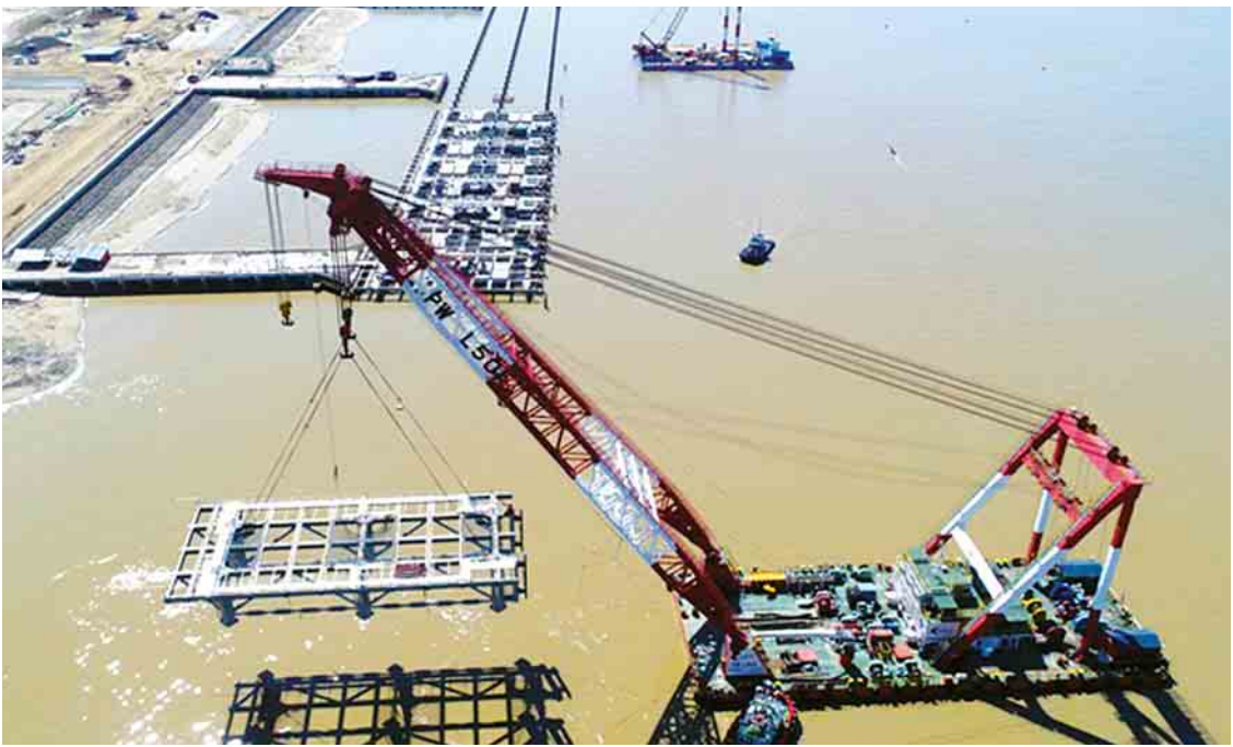
သီလဝါကမ်းနားဒေသဆိပ်ကမ်းတည်ဆောက်ရေးလုပ်ငန်းခွင်ကို တွေ့ရစဉ်။
