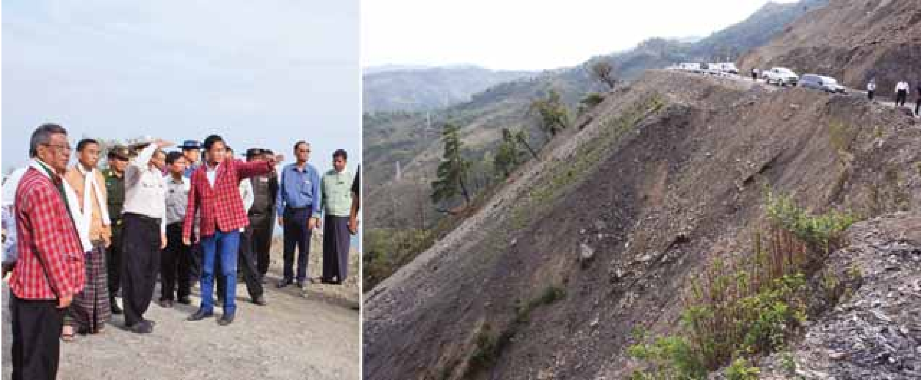
ကလေး-တီးတိန်-တွန်းဇံ လမ်းပေါ်ရှိ မြေထိန်းနံရံများ ကြံ့ခိုင်ရေးအတွက် ဆောင်ရွက်နေမှုများကို ဒုတိယသမ္မတ ဦးဟင်နရီဗန်ထီးယူ ကြည့်ရှုစဉ်။
