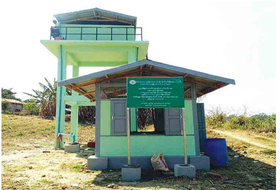
ဥတ္တရသီရိမြို့နယ် လောင်းတောင်ကျေးရွာ ကျေးလက်ရေပေးရေးလုပ်ငန်း ဆောင်ရွက်စဉ်။
