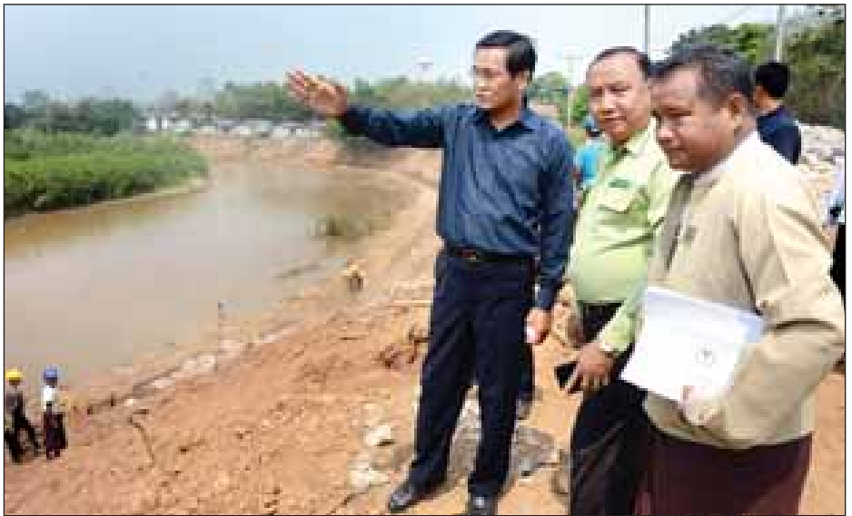
ဒုတိယသမ္မတ ဦးဟင်နရီဗန်ထီးယူ မယ်ဟောင်ချောင်း ကမ်းပြိုကာကွယ်ရေးလုပ်ငန်း ဆောင်ရွက်နေမှုကို ကြည့်ရှုစစ်ဆေးစဉ်။
