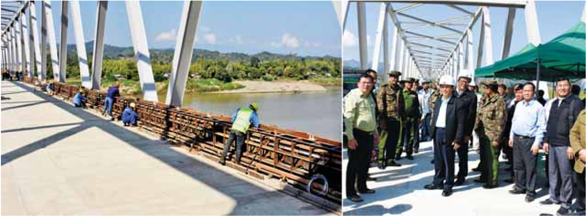
ချင်းတွင်းမြစ်ကူးတံတား(ခန္တီး) တည်ဆောက်ပြီးစီးမှုအခြေအနေများအား ဒုတိယသမ္မတ ဦးမြင့်ဆွေ ကြည့်ရှုစစ်ဆေးစဉ်။
