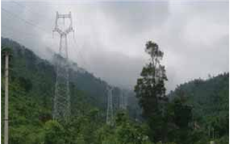
၂၃၀ ကေပွီ ဘီလူးချောင်း(၂) ရွှေမြို့ဓာတ်အားလိုင်း တည်ဆောက်ခြင်းလုပ်ငန်း ဆောင်ရွက်ထားရှိမှုအခြေအနေ
