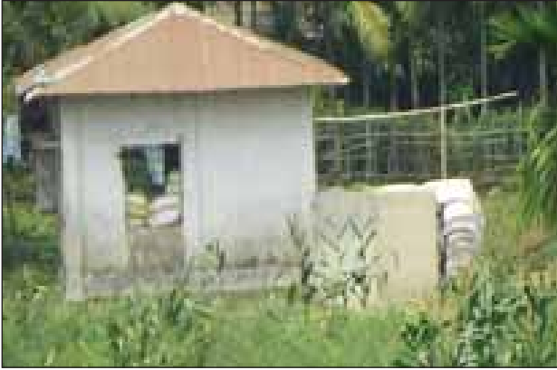
ဘင်္ဂလားဒေ့ရှ်နိုင်ငံဘက်ခြမ်း နှစ်နိုင်ငံနယ်နိမိတ်မျဉ်းနှင့် ခန့်မှန်း ပေ ၂၀ ခန့် အကွာနေရာတွင် ကွန်ကရစ်ဘန်ကာ တည်ဆောက်ထားမှုကို တွေ့ရစဉ်။
