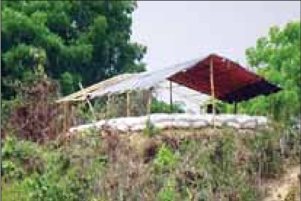
ဘင်္ဂလားဒေ့ရှ်နိုင်ငံဘက်ခြမ်း နှစ်နိုင်ငံနယ်နိမိတ်မျဉ်းနှင့် ခန့်မှန်း ၃၅ ပေခန့်အကွာနေရာတွင် သံအိတ်/မြေသား အိုဗာဟက်ပစ်ကျင်း တည်ဆောက်ထားမှုကို တွေ့ရစဉ်။
