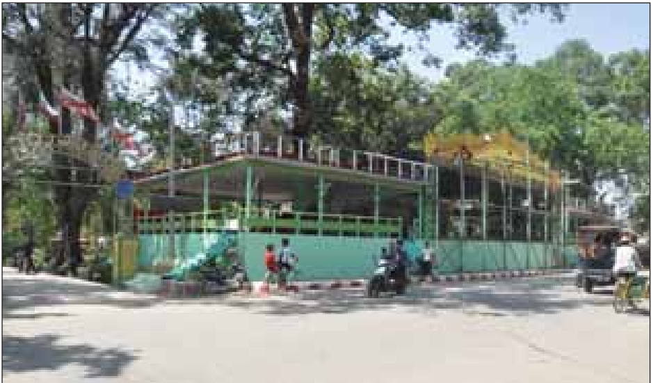
စစ်တွေမြို့ ဦးဥက္ကဋ္ဌမပန်းခြံရှေ့၌ ဗဟိုရေကစားမဏ္ဍပ်ဆောက်လုပ်နေမှုအား တွေ့ရစဉ်။
