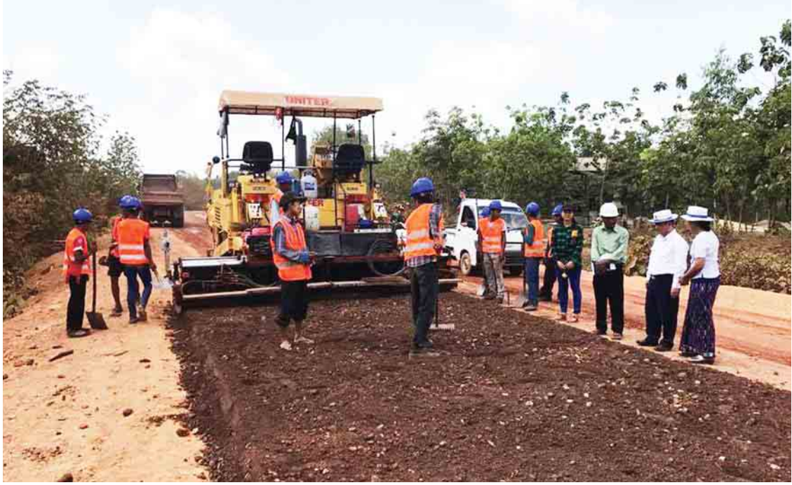
မုဒုံ-မြဝတီလမ်း(မဲသရော-လှိုင်းကွယ်အပိုင်း) လုပ်ငန်းဆောင်ရွက်နေမှုကို တွေ့ရစဉ်။
