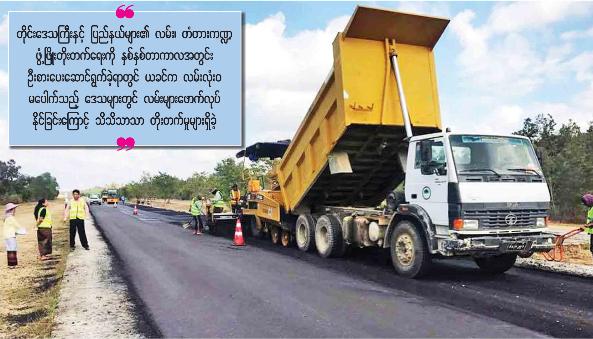
ရန်ကုန်-မန္တလေး အမြန်လမ်းတစ်လျှောက် လမ်းမျက်နှာပြင်ချောမွေ့ရန် လမ်းပိုင်းအလိုက် ကတ္တရာခင်းခြင်းလုပ်ငန်း ဆောင်ရွက်စဉ်။
