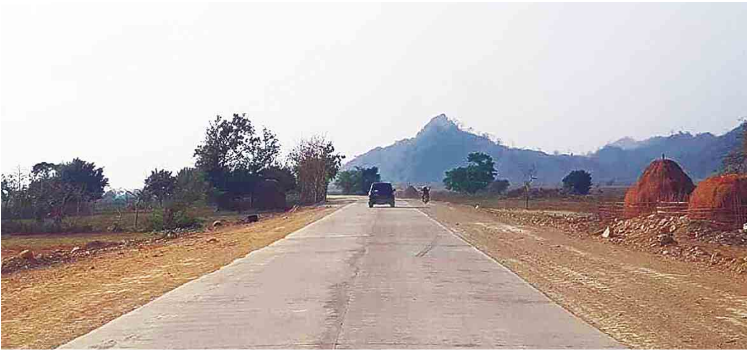
ရခိုင်ပြည်နယ် မောင်တောခရိုင်၌ အင်မော်-မောင်တောလမ်း(၄၉/၆)မိုင်အား ၁၈ ပေအကျယ် ကွန်ကရစ်ခင်းကျင်းထားမှုကို တွေ့ရစဉ်။
