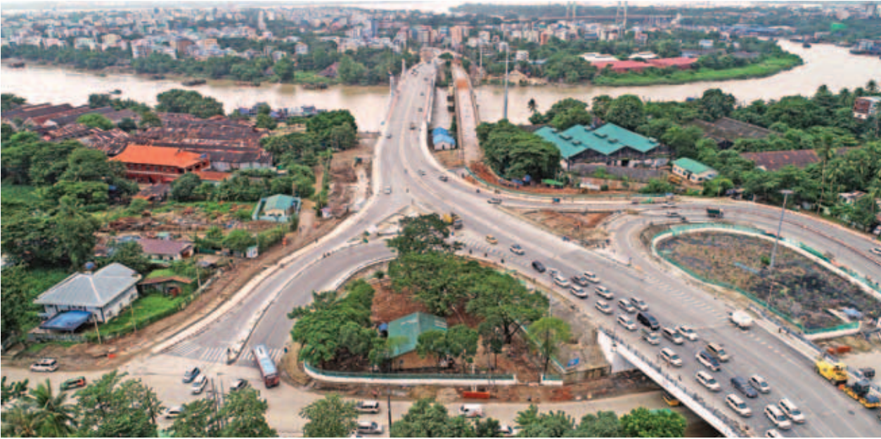
မင်္ဂလာတောင်ညွန့်မြို့နယ်နှင့် ဒေါပုံမြို့နယ်တို့ကို ဆက်သွယ်တည်ဆောက်ထားသည့် ဒေါပုံတံတားသစ်ကို တွေ့ရစဉ်။
